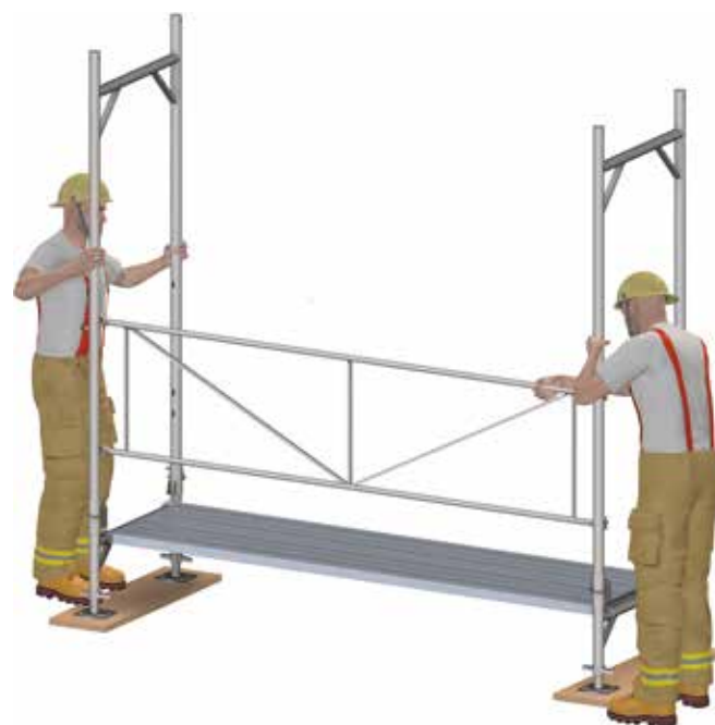
Figura 3: Installazione della prima campata.
