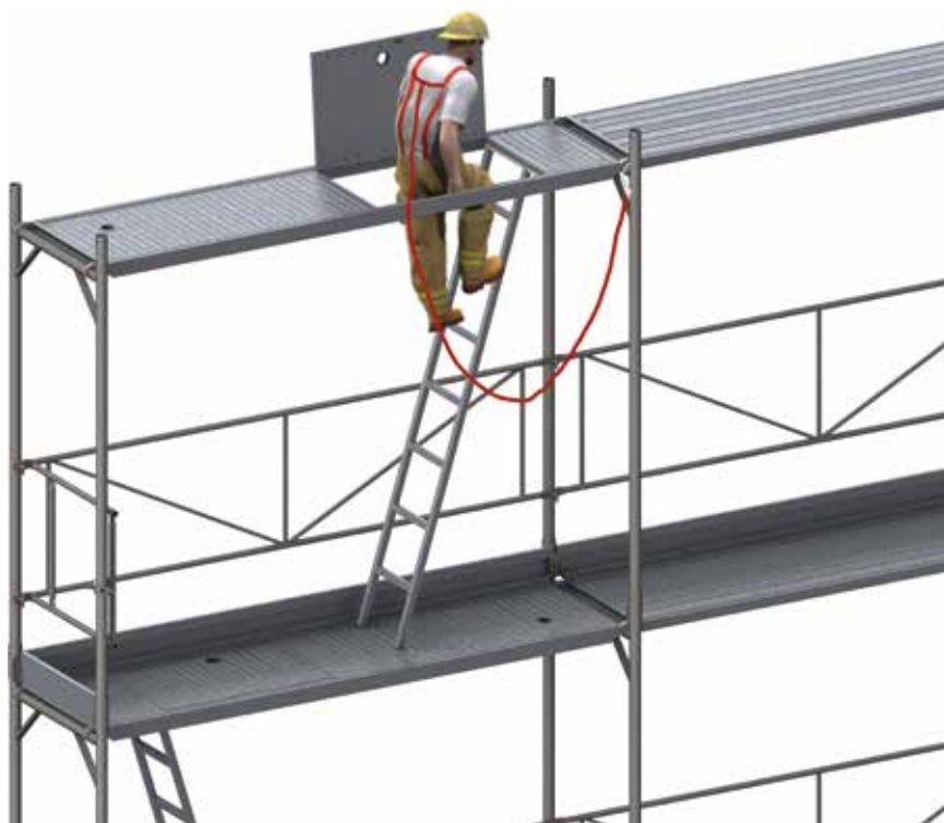
Figura 22: Fissaggio con il DPI anticaduta prima di accedere all'ultimo piano del ponteggio.
