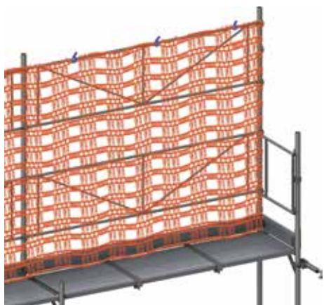
Figura 41: Rivestimento con reti.
