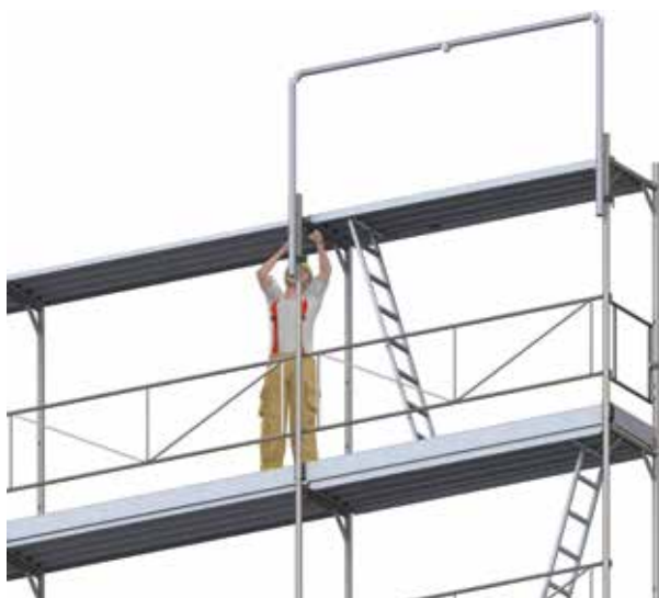
Figura 14: Montaggio del parapetto di protezione (MSG) nella campata superiore dal piano assicurato.
